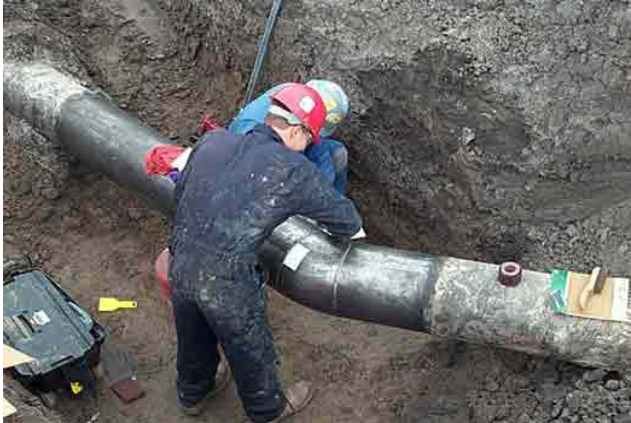
Cada manga PermaWrap es cortada, clasificada y numerada en la fabrica de WrapMaster's y, antes de ser instalada, es colocada en seco sobre la tubería para verificar su posición.
