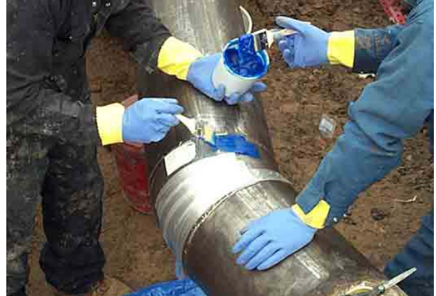
La almohadilla de fijación, la masilla "PermaPutty" y el adhesivo "PermaGrip" son colocados según el procedimiento de instalación.
