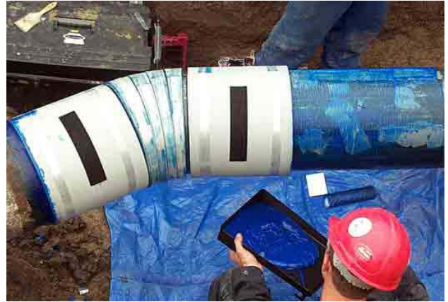
La foto demuestra las mangas PermaWrap al lado de la reparación del codo. El vacío de la zona del cordón de soldadura se llena con masilla de alta densidad PermaPutty y se colocan 2 mangas PermaWrap en las zonas a reforzar.
