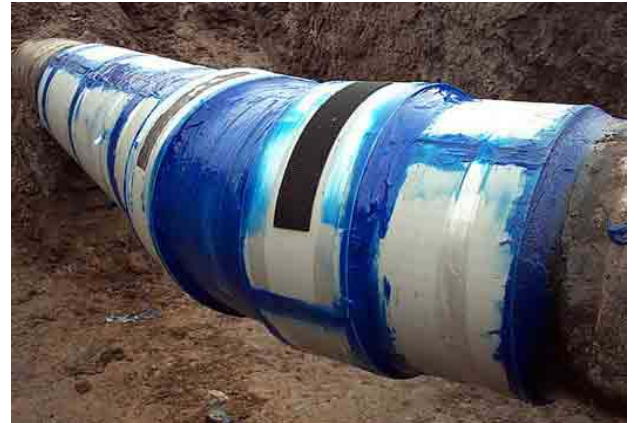
Esta foto demuestra la reparación final en la zona del codo, en donde se destacan las 2 mangas PermaWrap montadas por encima de la zona de soldadura circunferencial, las cuales refuerzan dicha zona.
