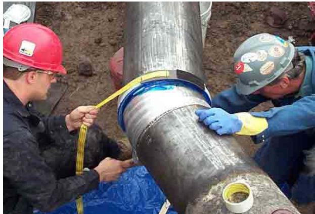
Utilizando los sujetadores Velcro suministrados en el kit, se aprieta cada manga con la barra de torque según el procedimiento de instalación.
