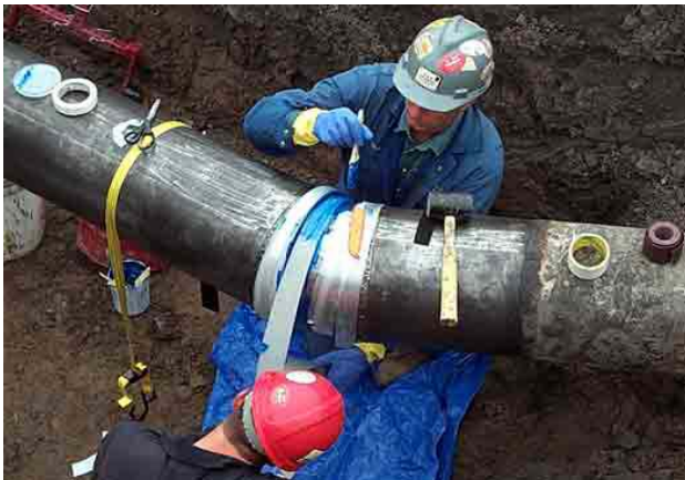
Se remueve el exceso del adhesivo PermaGrip y PermaPutty de cada borde y se colocan las demás mangas, numeradas en secuencia, según procedimiento de instalación.
