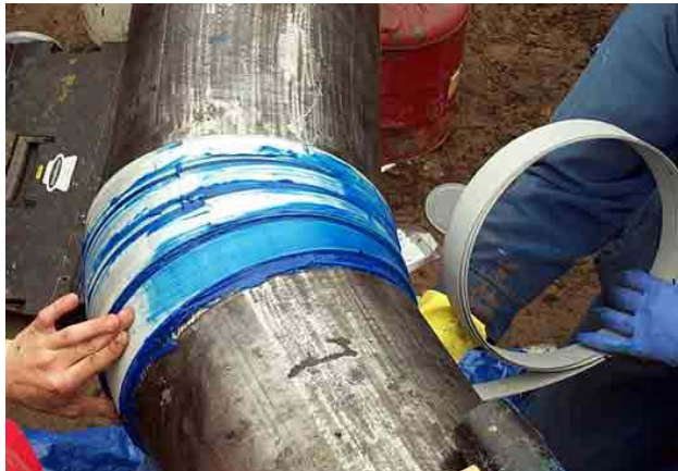
Al colocar la ultima manga, asegure limpiar cuidadosamente el exceso del adhesivo y la masilla.
