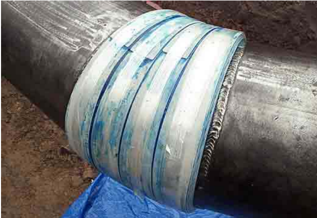
Es recomendable limpiar la instalación con solvente y un trapo. Si se está reparando corrosión en una zona de soldadura circunferencial, es recomendable utilizar una manga PermaWrap y efectuar una instalación según procedimientos para este producto.
